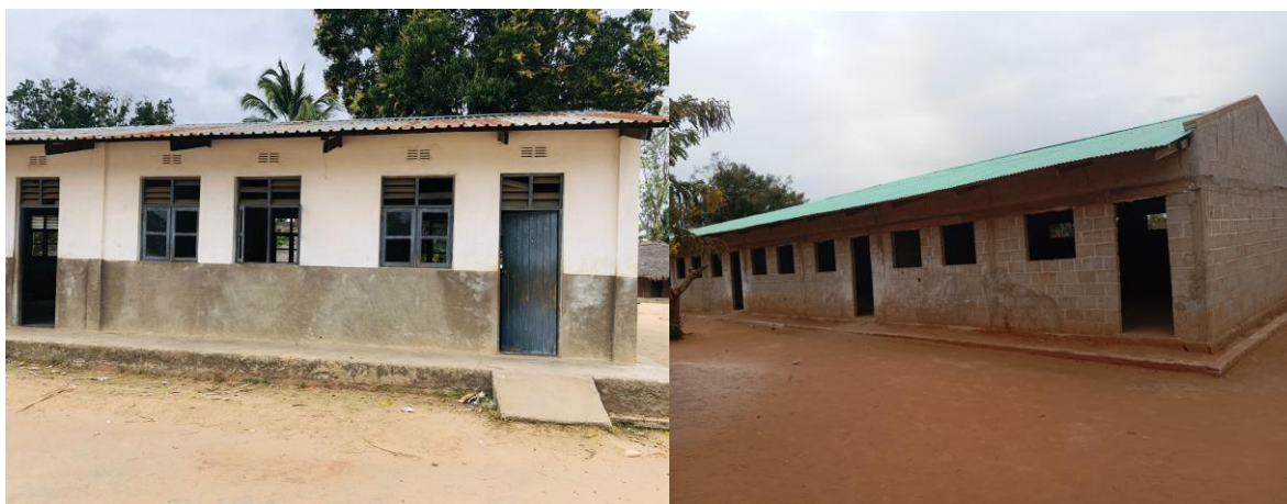
Figura 3: Acesso às salas de aulas
